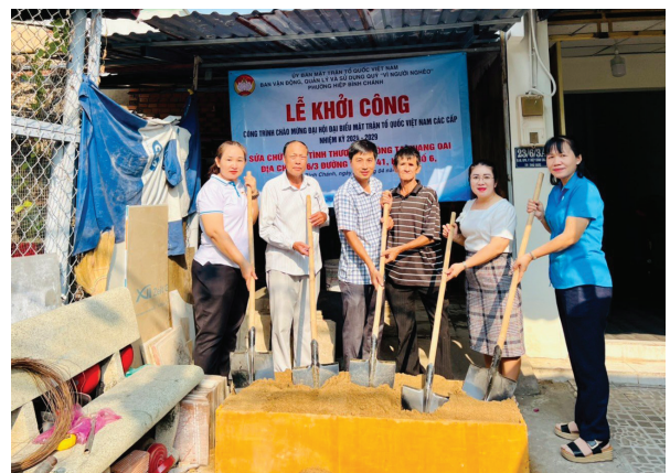
Lãnh đạo phường và khu phố tham dự lễ khởi công sửa chữa nhà tình thương.
