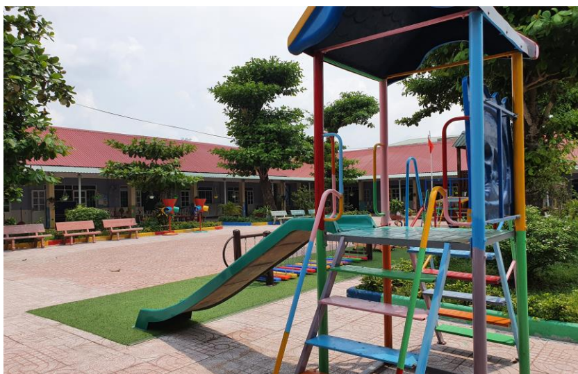
Điểm trường phía trước được sửa chữa từ năm 2016
