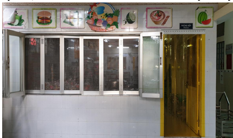
Bếp ăn bán trú được lắp hệ thống lưới-màn che chắn côn trùng đảm bảo vệ sinh an toàn thực phẩm
